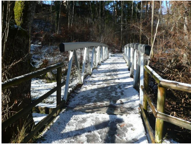
Brücke über den Kienbach
